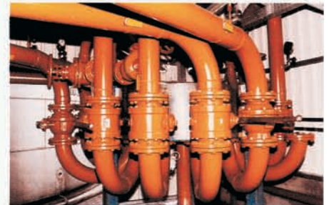
I.S.T. Flervägsväxventil: Knutpunkt för tankgrupp inom smörjoljeindustrin.
